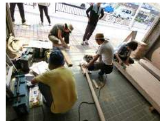
①部材の運び込みと組み立て準備。シャッターを上げ、街行く人に公開する。
